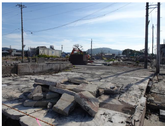
輪島朝市通。火災で焼け落ちた瓦礫は撤去され、基礎が剥き出しになっています。
